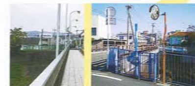
津波などによる川の氾濫や橋の崩落で渡れない可能性あり
