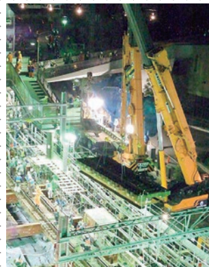
桁撤去作業
