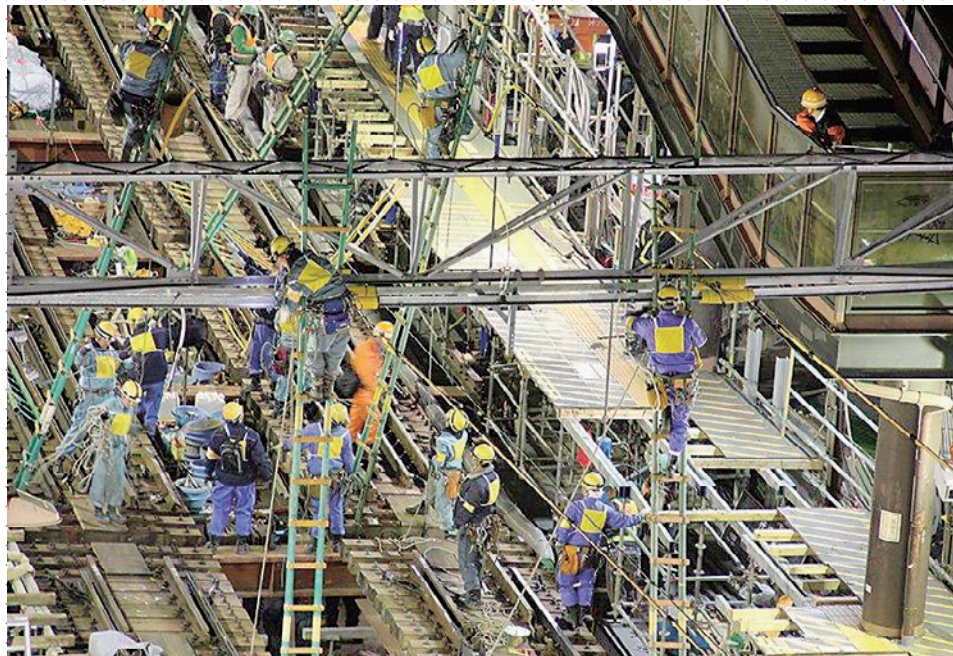
桁撤去作業
