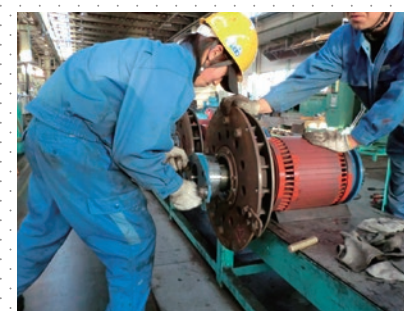
主電動機組み立て作業
