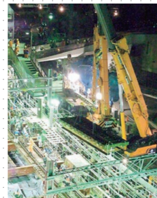
桁撤去作業
