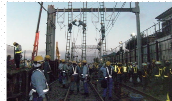
【竣工】2012年8月 【施工】電設事業本部 電力工事業部・信号工事業部
