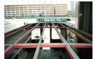
骨組みだけが残る屋根部分
