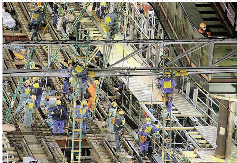
【竣工】2013年3月 【施工】電設事業本部 電力工事業部・信号工事業部・電設工事業部
