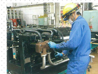
コンプレッサー整備作業
