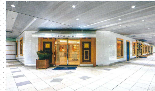
【竣工】2017年7月 【施工】電設事業本部 電気・通信部
