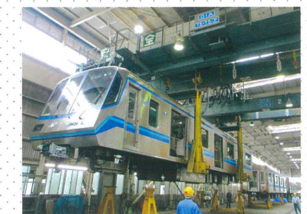
台車取り付け作業
