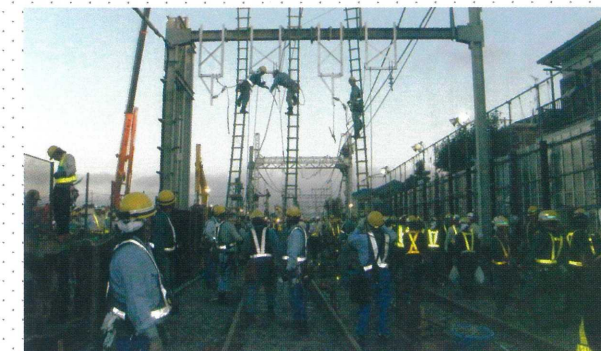
【竣工】2012年8月 【施工】電設事業本部 電力・信号部
