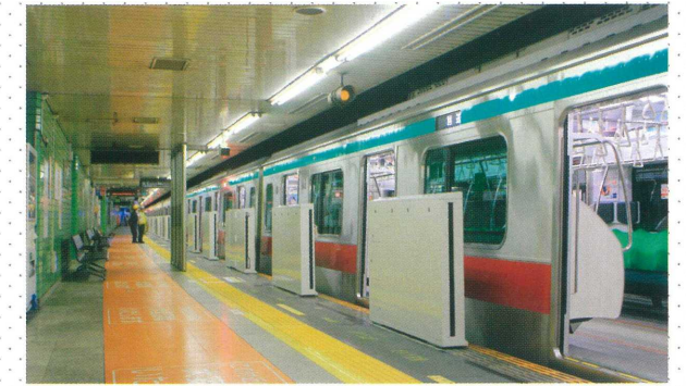
【竣工】2018年3月 【施工】電設事業本部 電気・通信部
