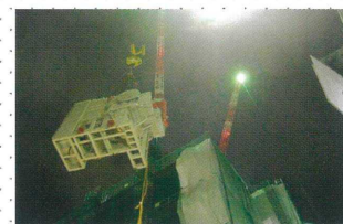
特別高圧用遮断器を渋谷変電所に搬入
