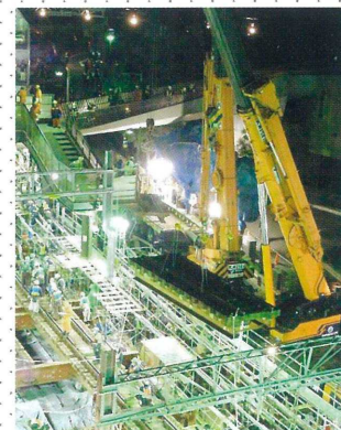
桁撤去作業
