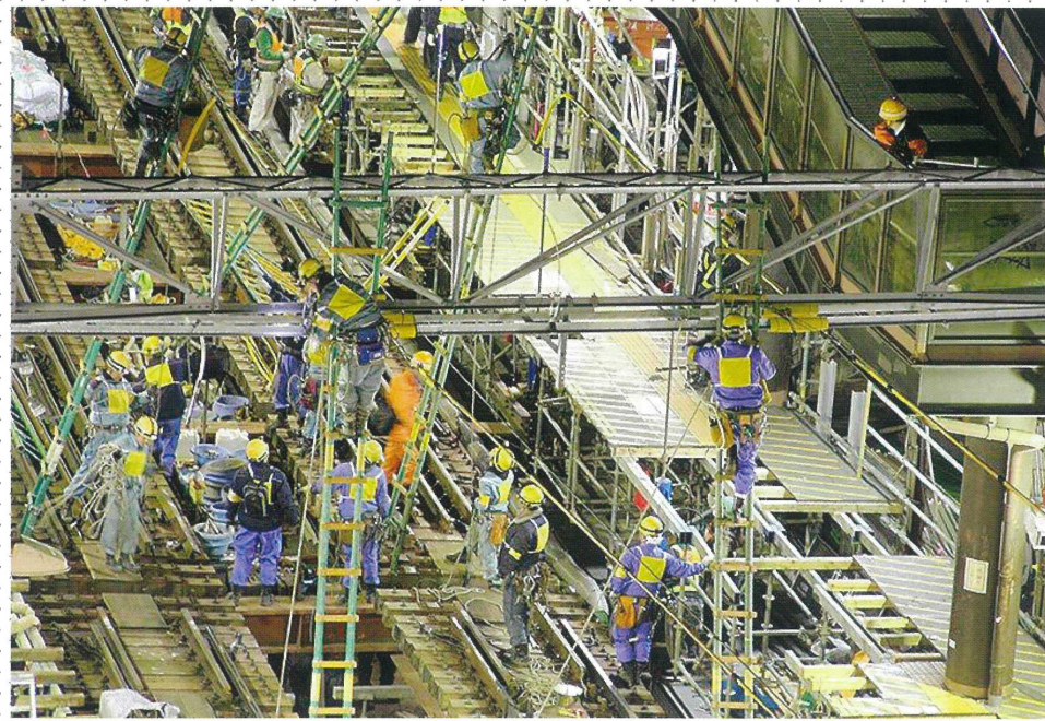
【竣工】2013年3月 【施工】電設事業本部 電力・信号部、電気・通信部
