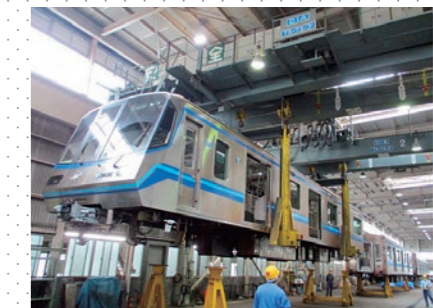
台車取り付け作業
