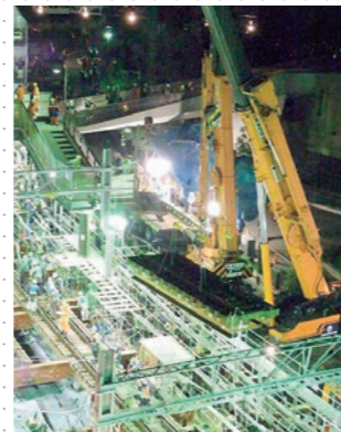
桁撤去作業
