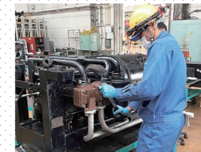
コンプレッサー整備作業
